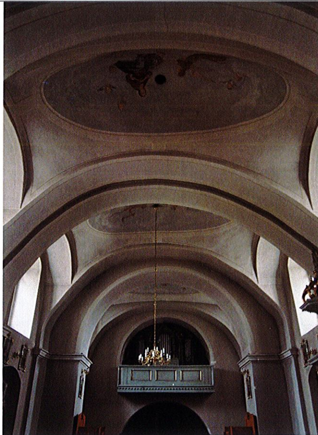
Fot. 4. Widok ogólny na sklepienie
