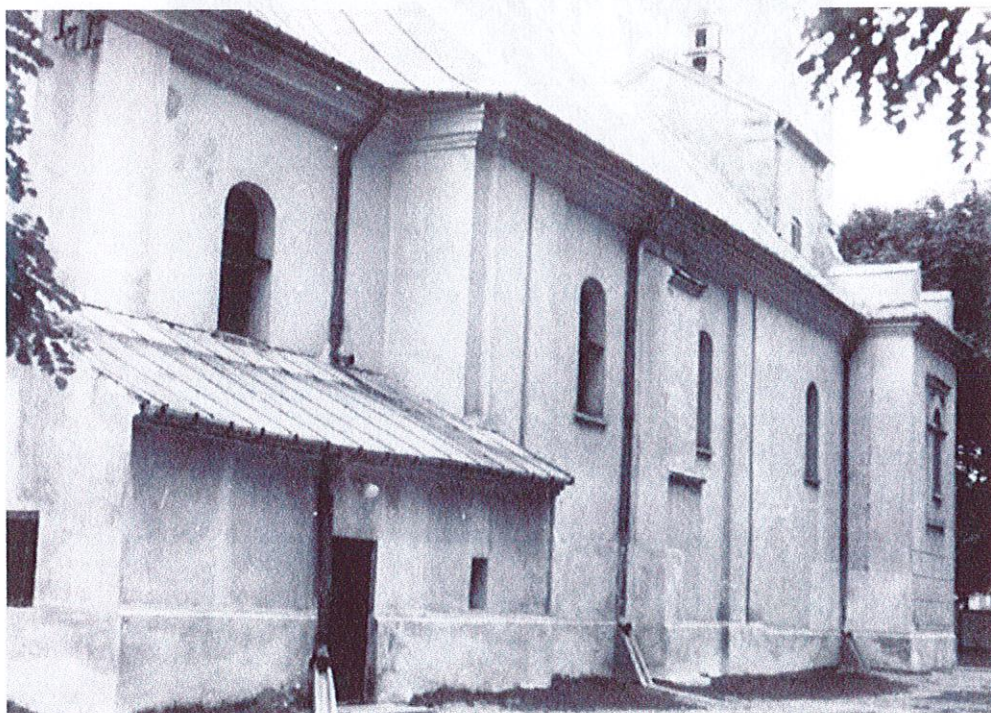
Fot. 3 Kościół św. Wawrzyńca w latach 60-tych XX wieku (elewacja zachodnia)
