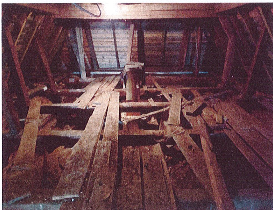
Fot. 28 Więżba dachowa nad prezbiterium
