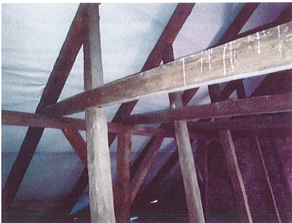
Fot. 27 Więżba dachowa nad nawą
